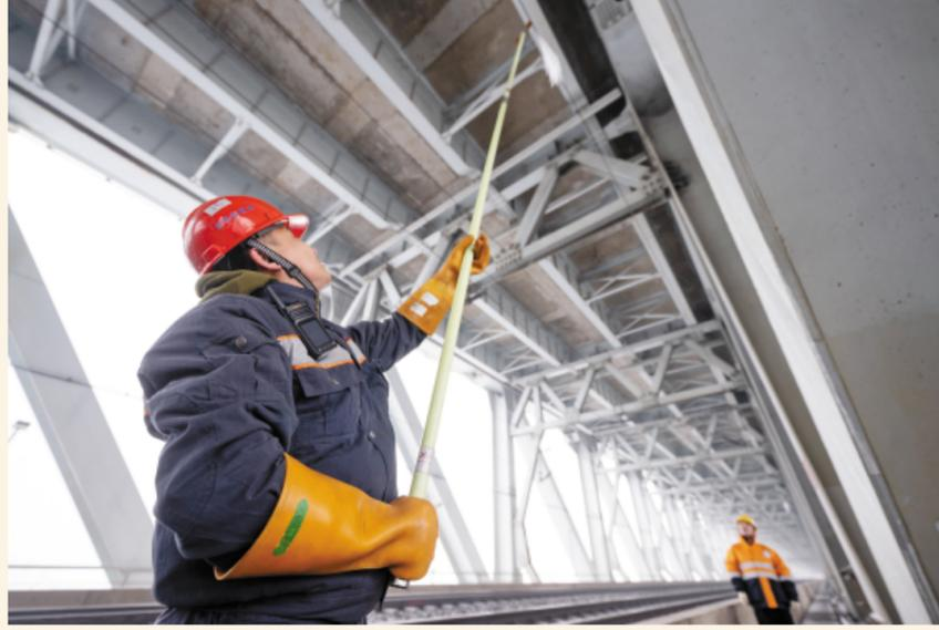
▼2月4日，在位于京广大动脉上的武汉天兴洲长江大桥上，武汉供电段工人在天窗期对铁路接触网设备进行除冰作业。
